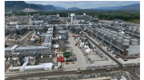
LNG Canada Project
